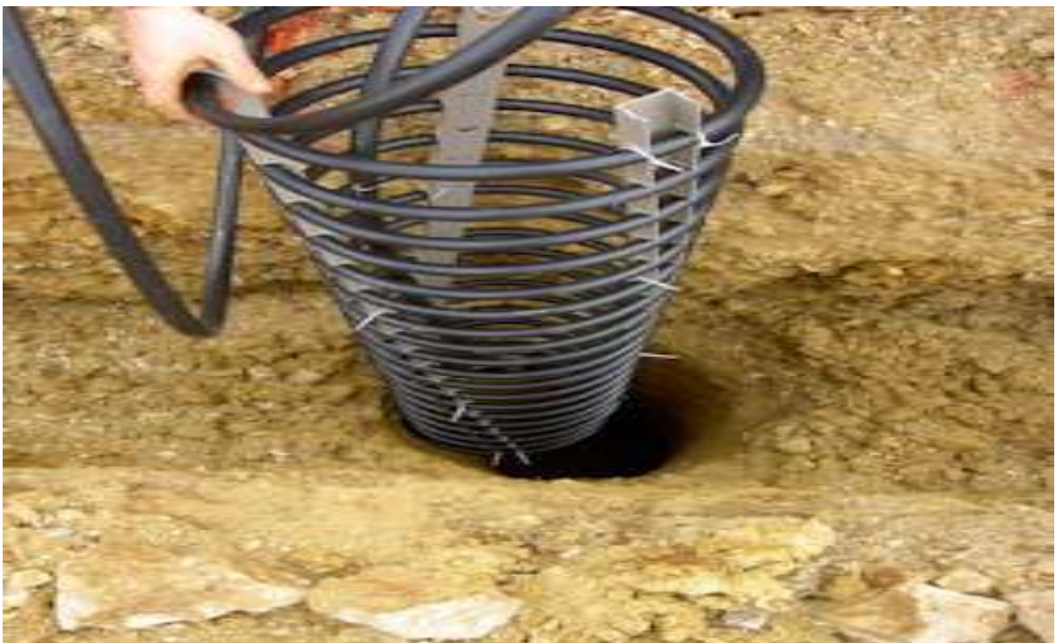
(2-rasm. Vertikal geotermal issiqlik nasosi )
