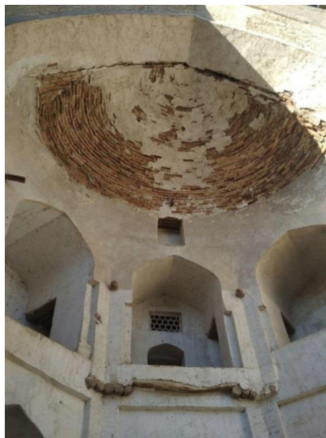
7-расм. Абдулазизхон мадрасаси биносининг ички ҳовлига (ғарб томонга) қараган портал гумбази ашёларини ёғингарчилик таъсирида намланиши ва емирилиш ҳолати юзага келган
