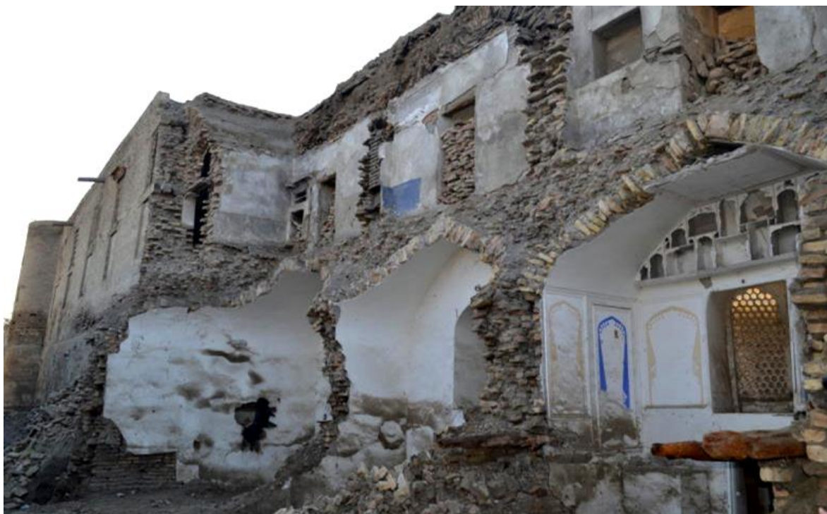
3-расм . Абдулазизхон мадрасаси биносининг шарқий деворининг бир қисми қулагандан кейинги ҳолатининг 2018 йилдаги тасвири
