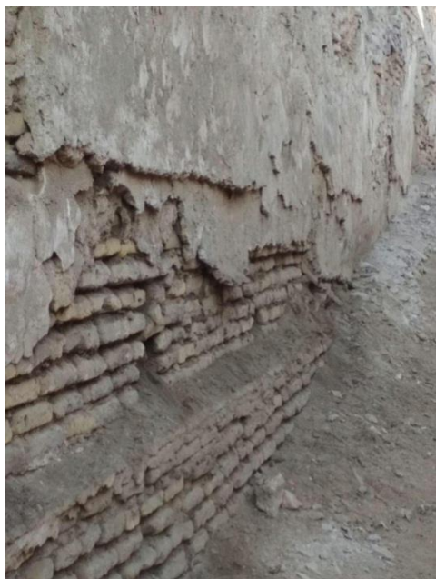
6-расм. Абдулазизхон мадрасаси биносининг шарққа қараган девори фрагменти; қурилиш қоришмаси тўлиқ, ғиштлар қисман емирилган
