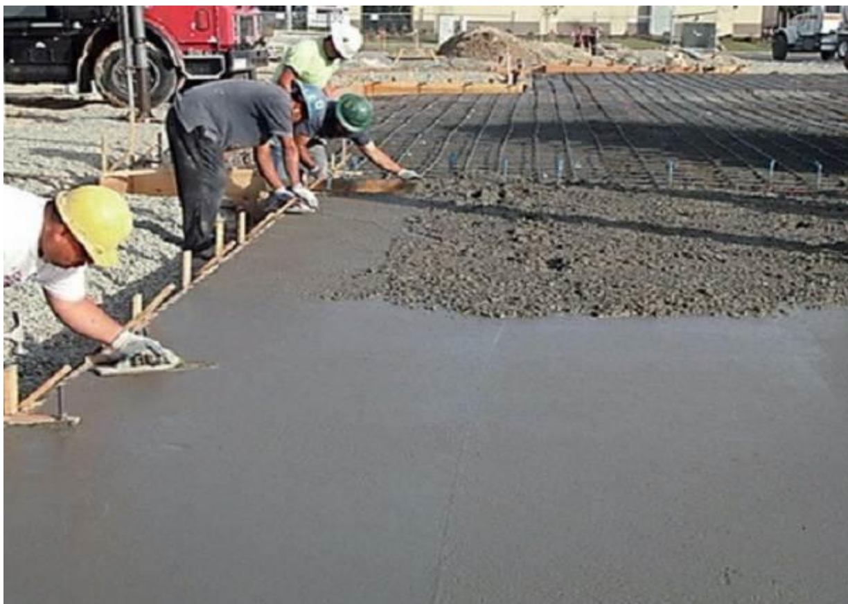
1-расм. бетон қоришмасини пластификаторлар қўллаб ётқизилиши
