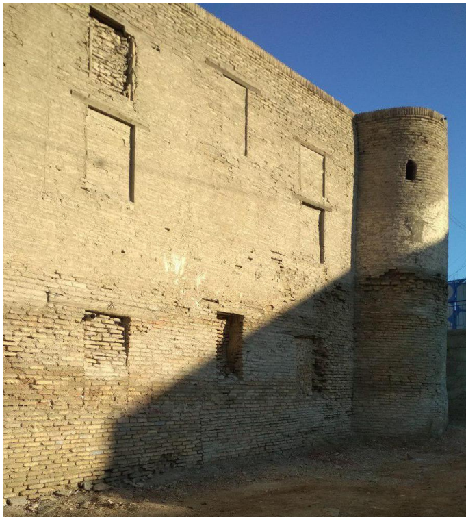
4-расм. Абдулазизхон мадрасаси биносининг жанубга қараган (шарқ деворга яқин қисми) деворининг қоникарсиз техник ҳолати (2019 йилги сурат)
